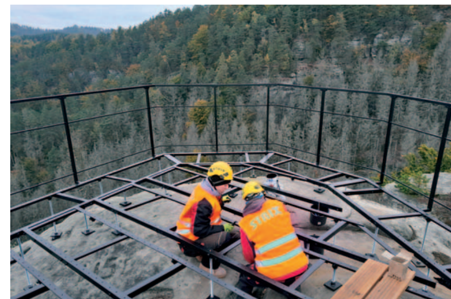
Instalace pochozích konstrukcí na Šaunštejně. © Pavel Svoboda
