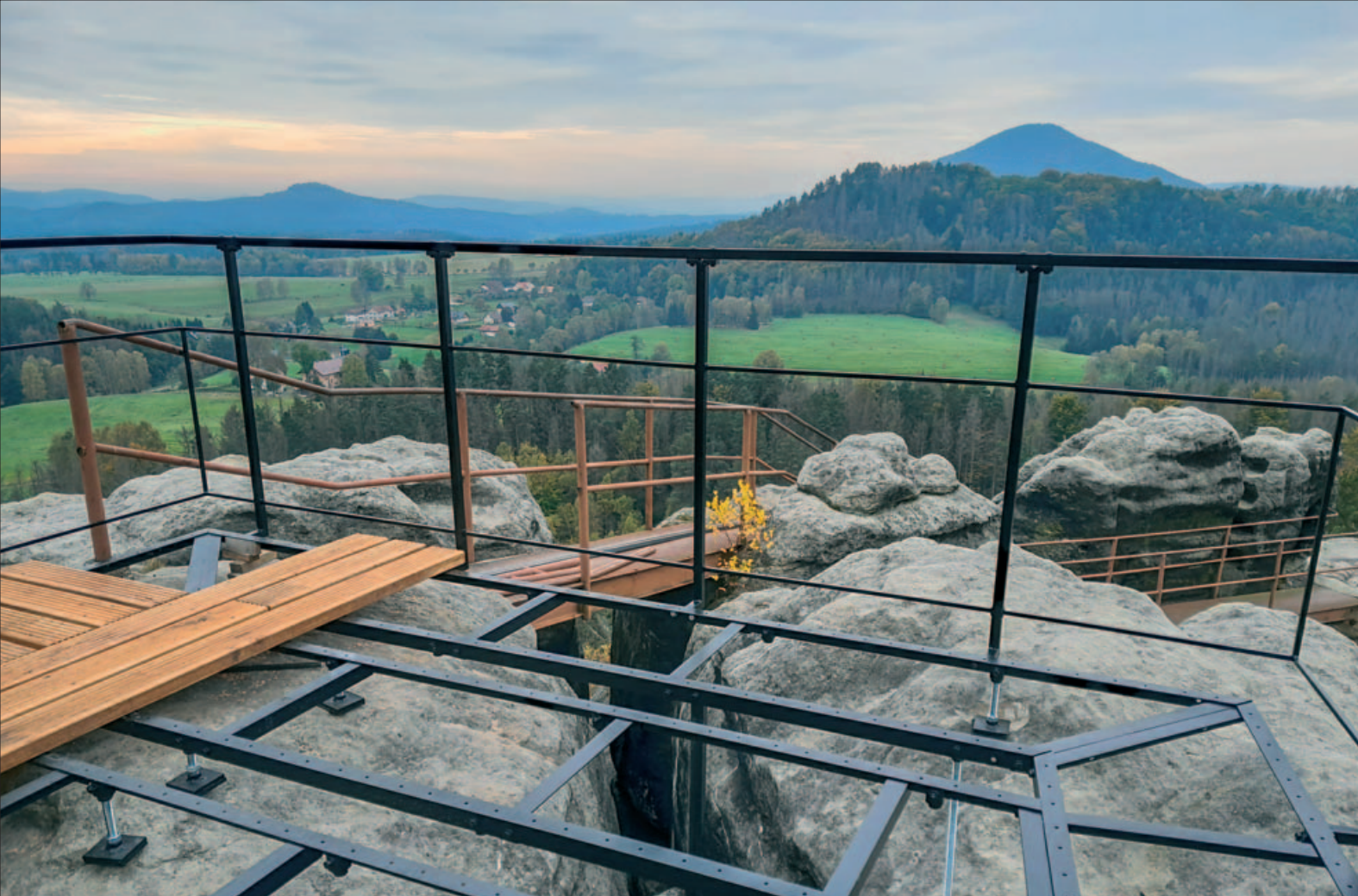
Instalace pochozích konstrukcí na Šaunštejně. © Pavel Svoboda
