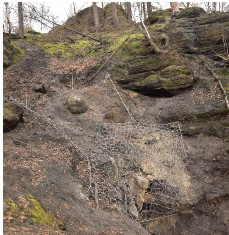
Obr. 7 Objekt č. 4 byl zajištěn kotvenou ocelovou sítí.
