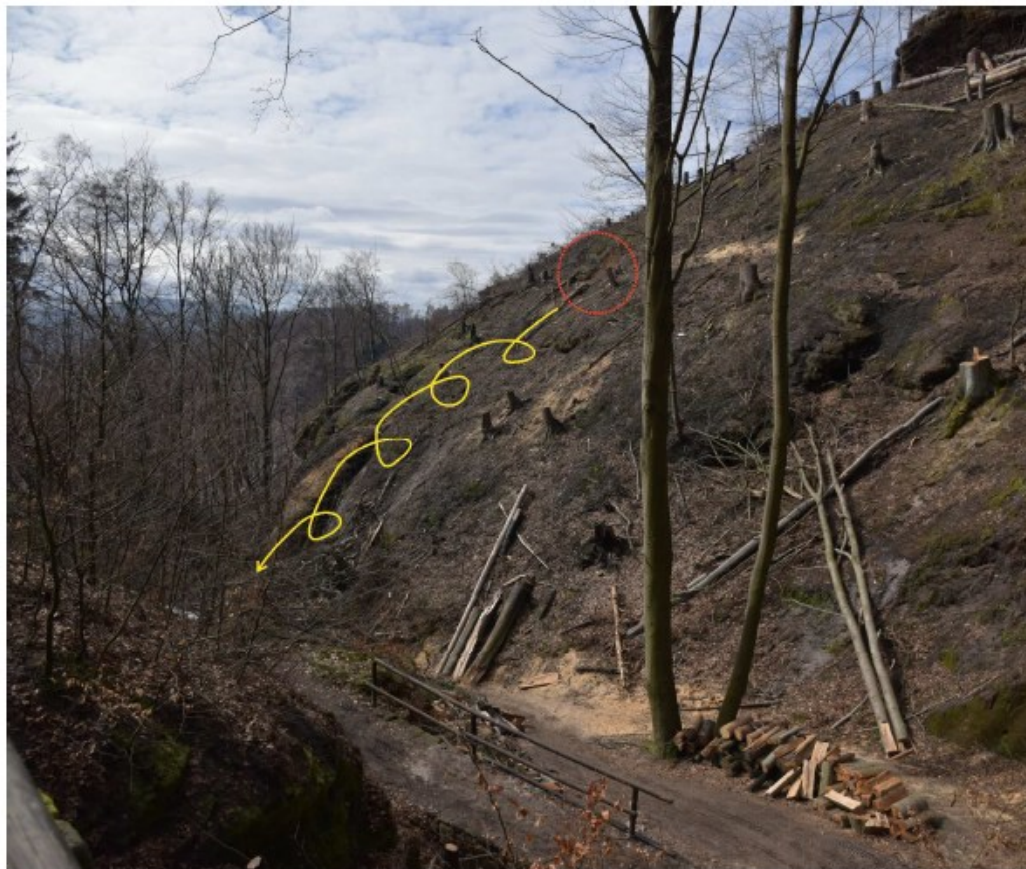
Obr. 13 Při kácení v úseku DD5 byl odhalen skalní objekt v nepříznivé pozici nad stezkou k Pravčické bráně (u serpentýny). Objekt byl operativně odtěžen (samostatná akce SNPČŠ zadaná odborné firmě, bez dokumentace ČGS).
