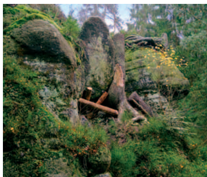
Sanace skalního bloku v Kyjovském údolí. Marek Král
