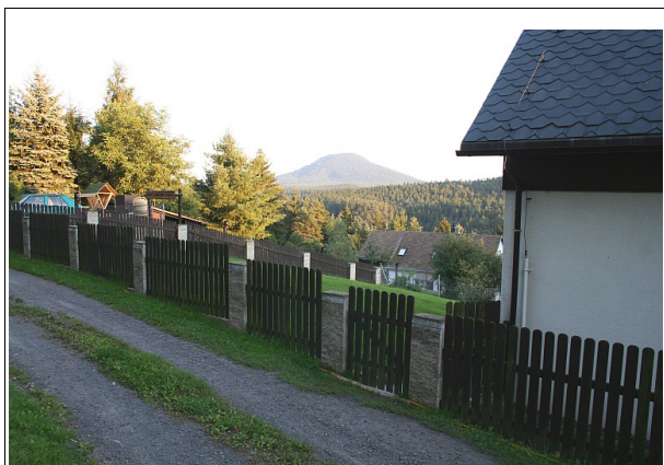
Fig. 28: Méně vhodné řešení kombinace sloupků ze „stípaného“ betonu a lačkového plotu Mezná).
