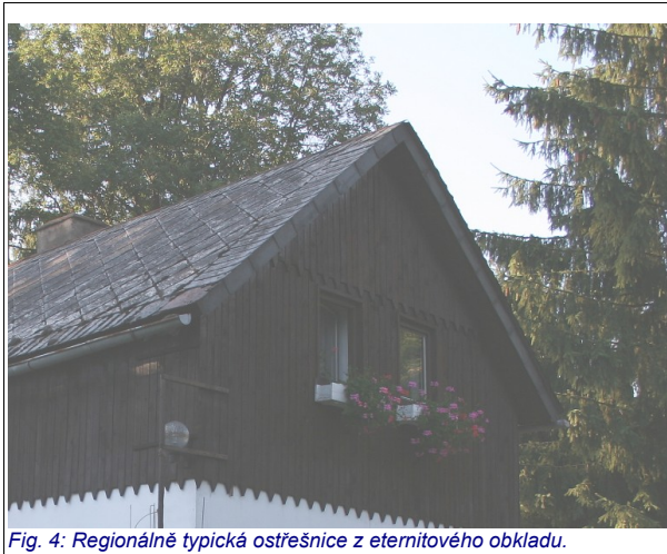
Fig. 4: Regionálně typická ostřešnice z eternitového obkladu.
