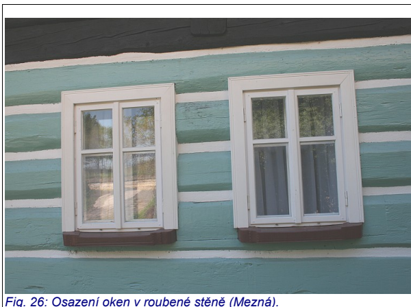
Fig. 26: Osazení oken v roubené stěně (Mezná).
