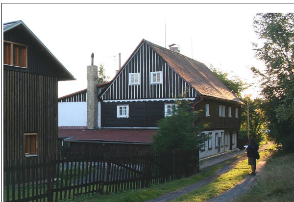
Fig. 10: Komín umístěný mimo hřeben a hlavní budovu (Mezná).
