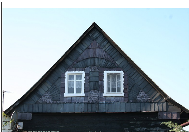
Fig. 19: Obklad štítu břidlicí, mistrovská ukázka řemesla a citu pro materiál (Mezná).
