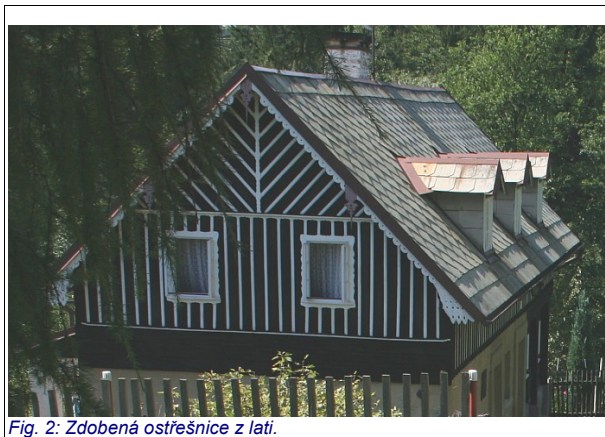
Fig. 2: Zdobená ostřešnice z latí.
