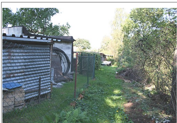
Fig. 42: Nevhodné řešení hospodářských staveb v okraji zástavby (Růžová).
