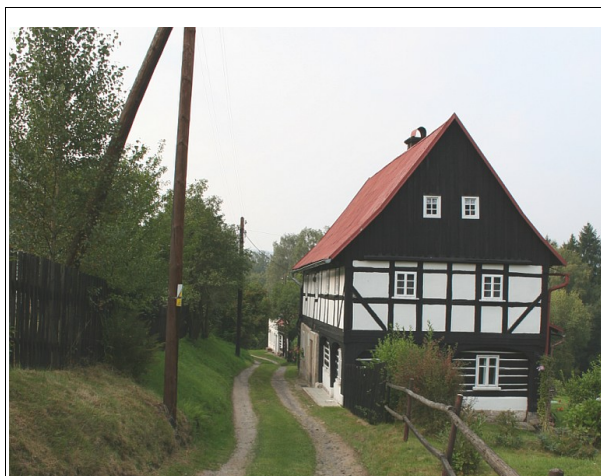
Fig. 1: Místně obvyklý přesah krovů bez přesahu nad zápraží.
