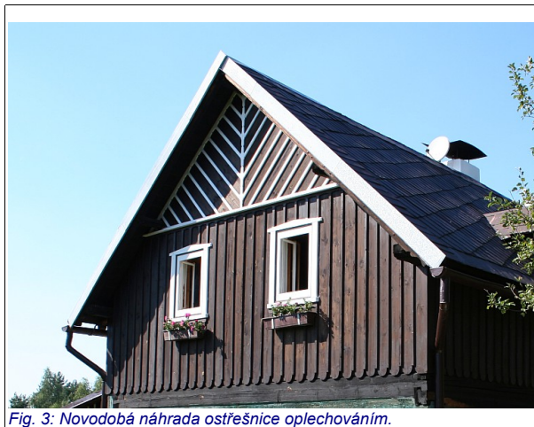
Fig. 3: Novodobá náhrada ostřešnice oplechováním.
